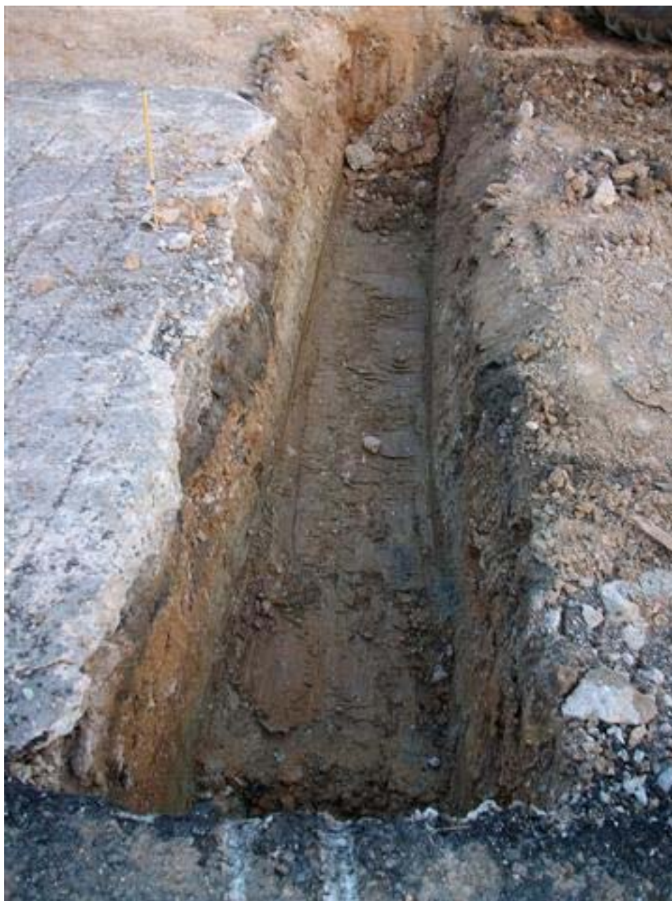
Detall del tram final de la rasa a la carretera de Montjuïc, al punt on es va assolir més fondària.
