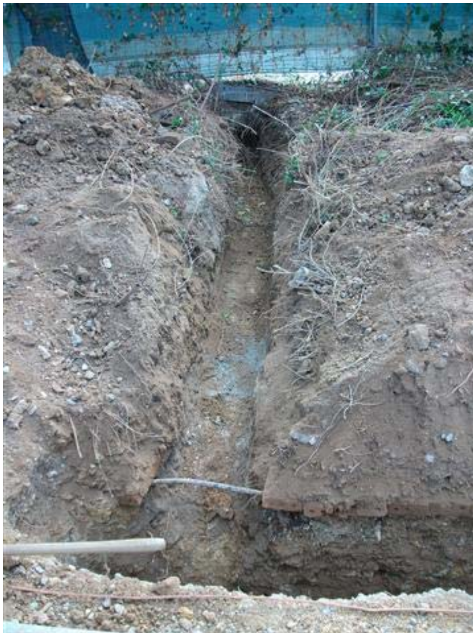
Detall d'una de les rases secundaries per connectar embornals.
