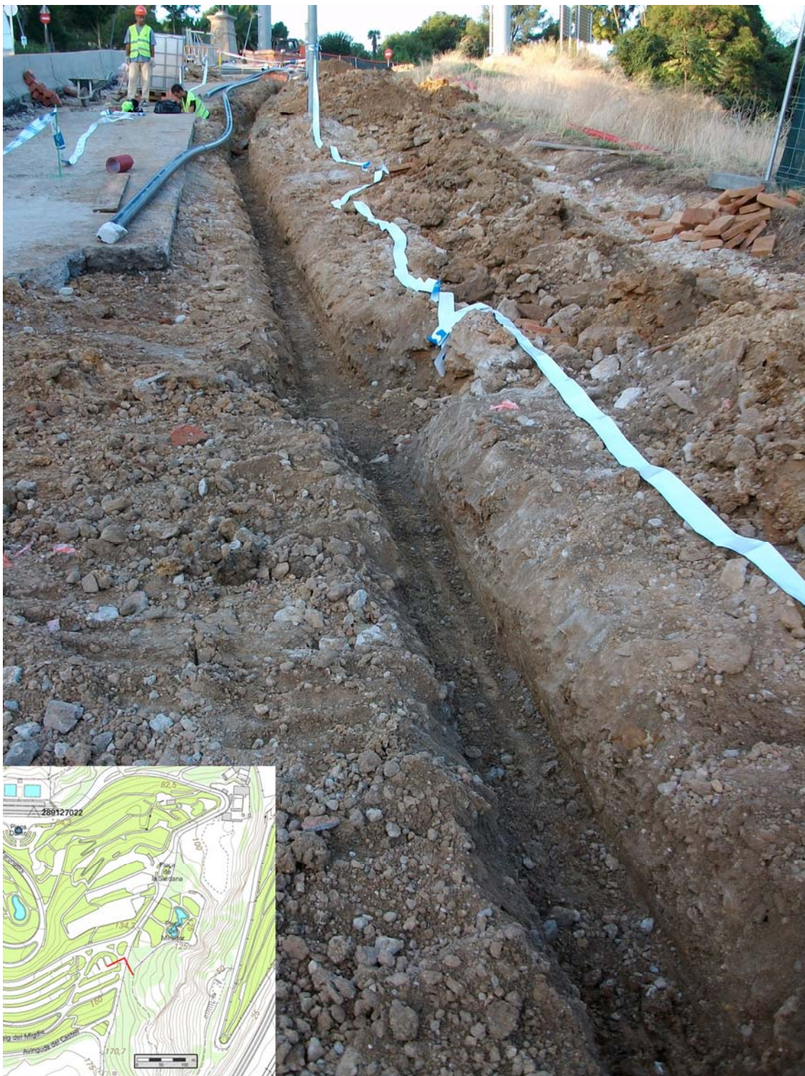
Vista del tram de rasa excavada al tram inicial de la obra (Avinguda del Castell)
